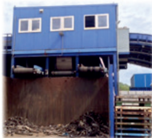
Be- & Entlüftung von Sortierkabinen
