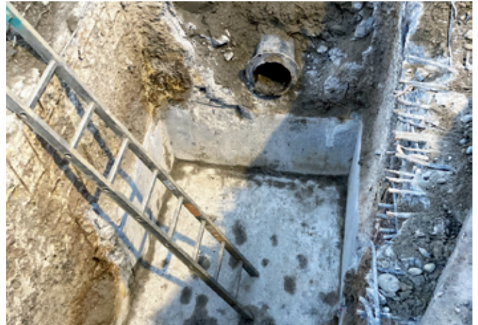
Minimaler Eingriff, maximaler Nutzen: In nur vier Tagen wurde ein korrodierter Betonschacht in Breisach am Rhein gegen einen AWASCHACHT PP aus Polypropylen ausgetauscht.
